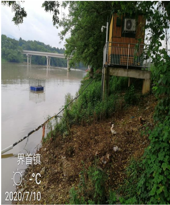
(3) 管线区监测照片:
