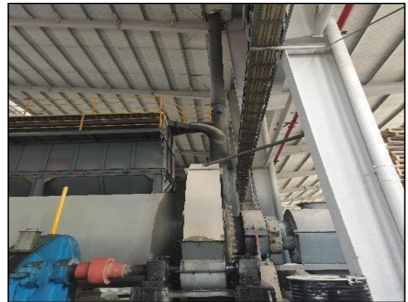
球磨工序布袋除尘及排气筒
