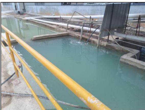
生产废水沉淀池
