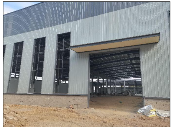
项目南面在建厂房
