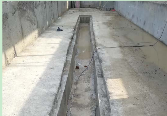
项目截排水沟建设情况
