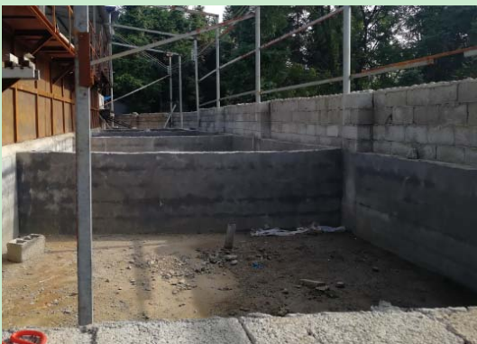
项目循环水池建设情况
