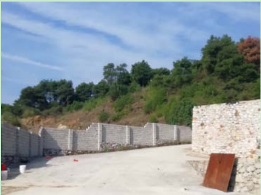
项目西面现状
